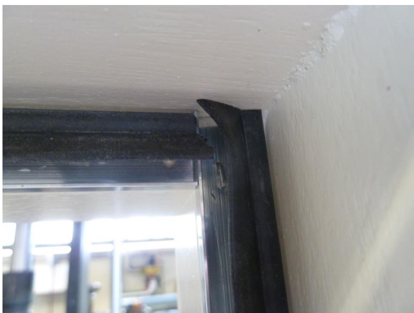
Foto 4 De elastische dichtingsprofielen en de aluminiumhouderprofielen zijn stuikend aangebracht. (foto van AIB 3N XL)
